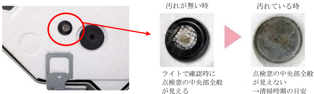
(図7) ドレンパン点検窓 確認例
