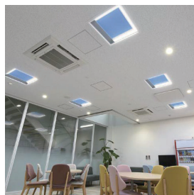
昭和電業株式会社 本社ビル (大阪府)
