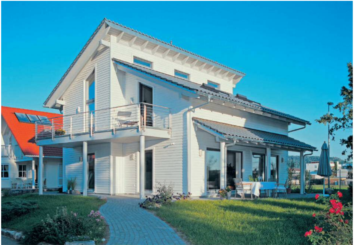
施工例：外壁に#2101 ホワイト2回塗り
