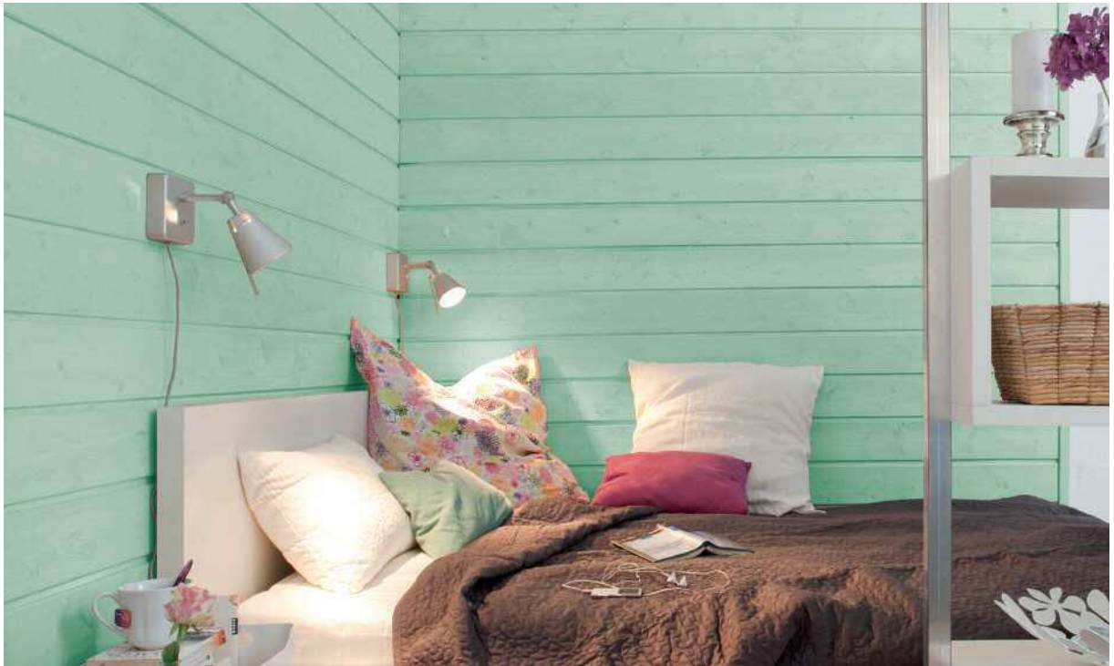
施工例：壁に#3131 グリーン5gと#3188 白色を100gを混ぜた色を2回塗り
