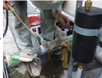
液管側に「α-HT」接続
