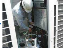
真空引き、冷媒再充填、試運転
